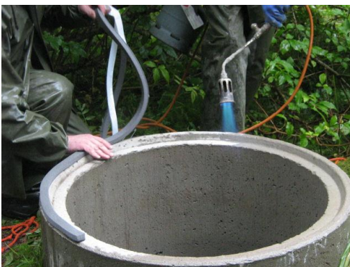
Solumuovitiivisteiden asennus. Renkaan pinta kuivataan ensin kuumailmapuhaltimella, jotta tiiviste pysyy varmemmin paikoillaan. Kuva: Sanna Vienonen
