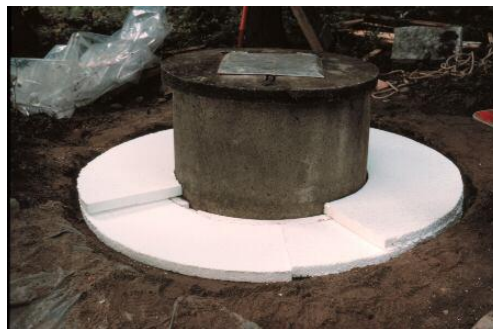
Rengaskaivon routaeristys vaakasuorassa. Kuva: Erkki Santala
