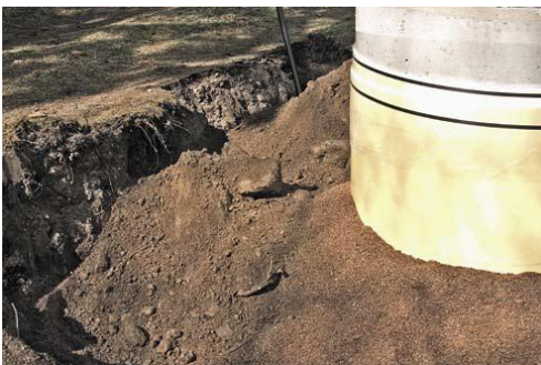
Rengaskaivon routaeristys. Kuva: Tuomo Hatva
