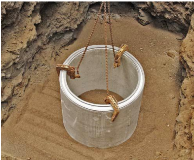
Alimman kaivonrenkaan asennus. Kuva: Tuomo Hatva
